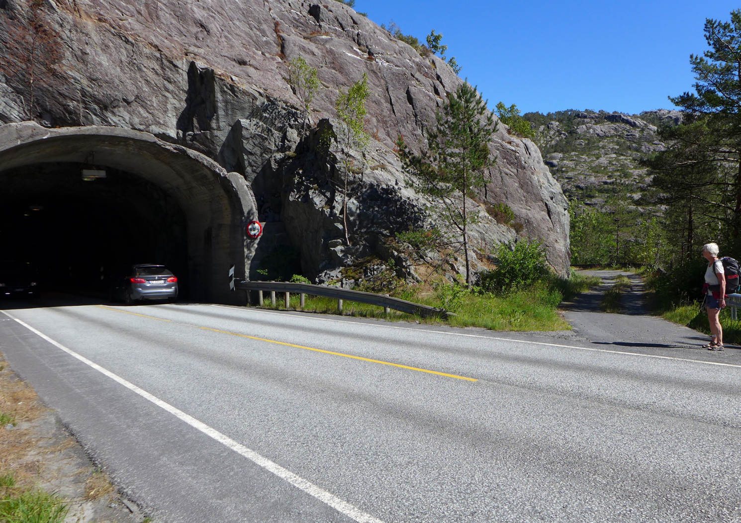
Grasdalsstunnelen går det heldigvis kjerrevei rundt.
